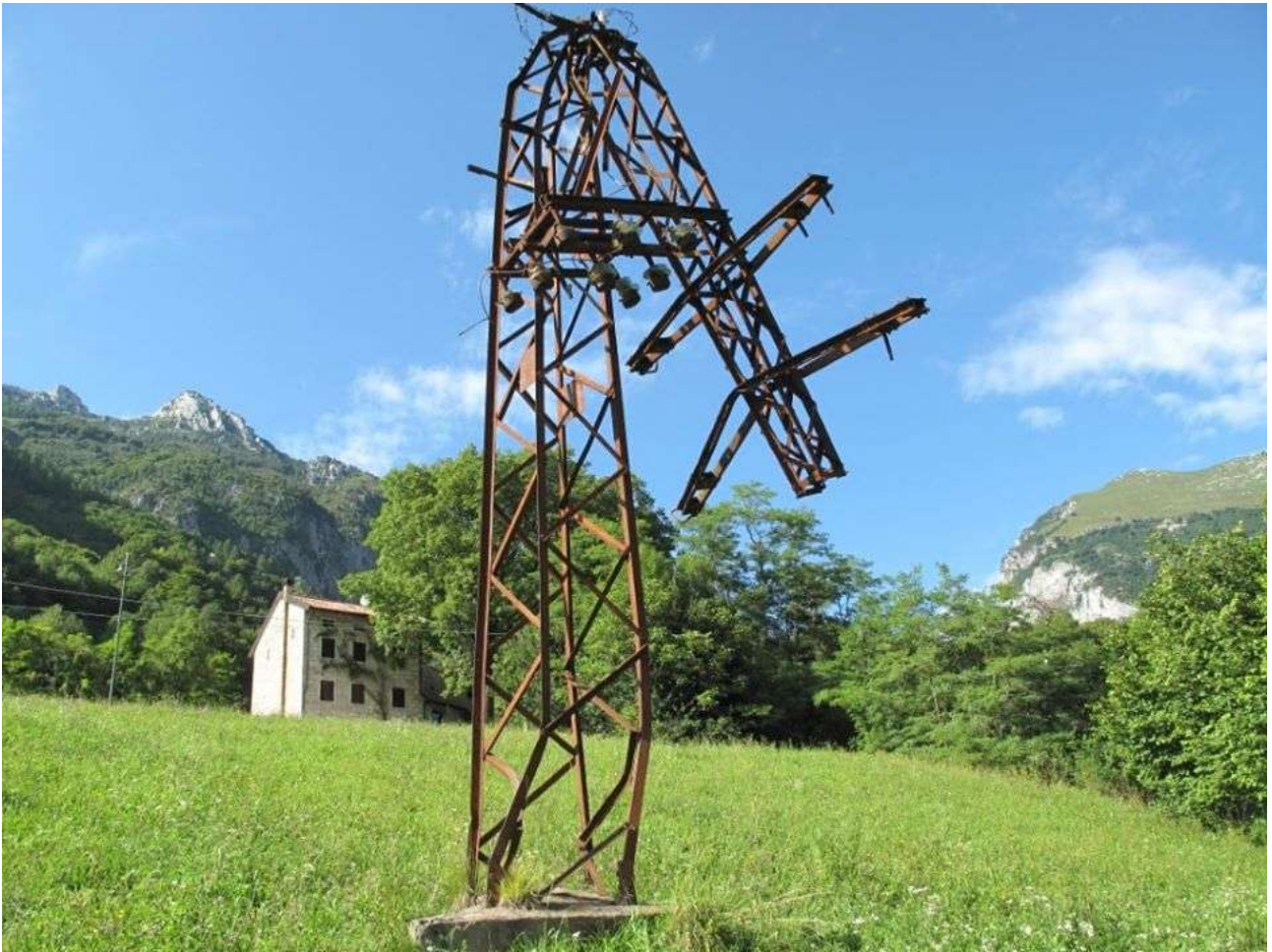
Erto e Casso, sponda destra della Valle del Torrente Vajont, traliccio elettrico deformato dall'ondata
